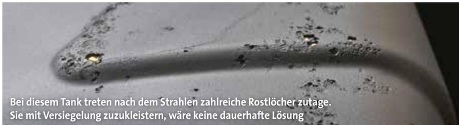
Bei diesem Tank treten nach dem Strahlen zahlreiche Rostlöcher zutage. Sie mit Versiegelung zuzukleistern, wäre keine dauerhafte Lösung
